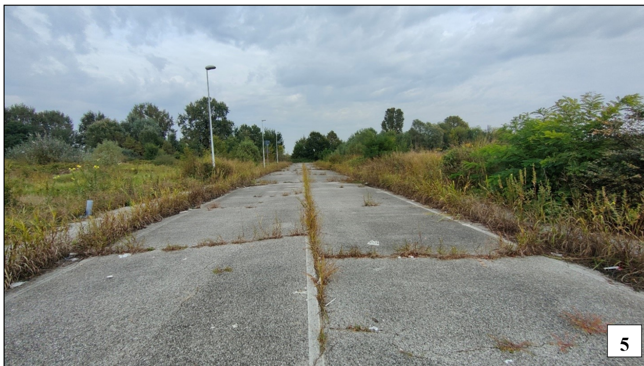
5. Strada frapposta tra i due lotti
